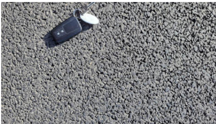
15. ábra – Az elkészült AC 8 AZ (alacsony zajszintű) aszfaltburkolat felületi képe a kísérleti építés után
