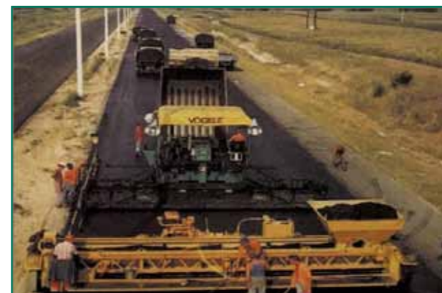
Érdesített homokaszfalt készítése.
