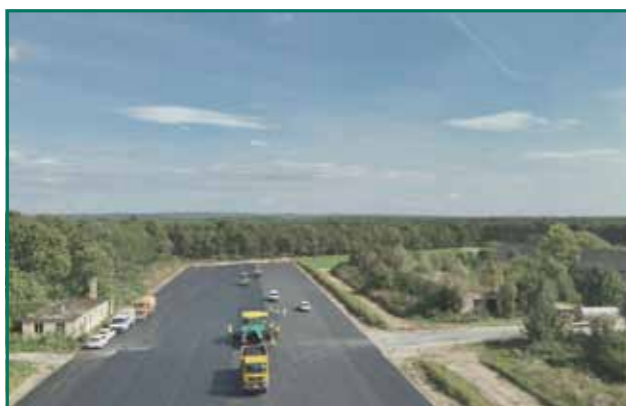
1. kép Tét, aszfaltkeverő, próbaszakasz
