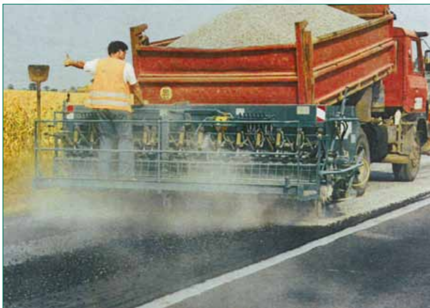
Nagy teljesítményű felületi bevonat készítő gép autópályán.
