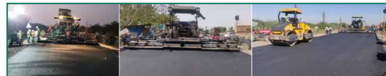
10. ábra: PGXpand módosított bitumen alapú keverékkel épített autópályák
