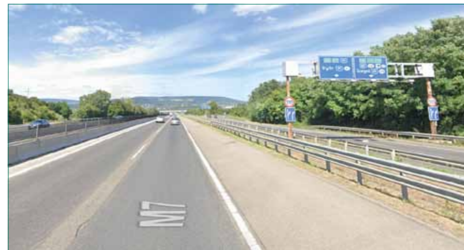
6. ábra: A gyűjtő-elosztó pálya bal oldali jelzőtáblája a főpálya jobb oldali jelzőtáblájának is tűnhet
