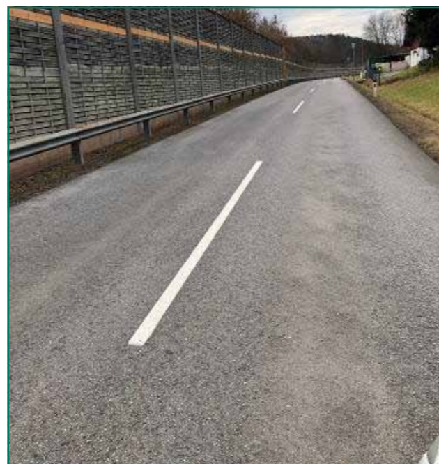
1. ábra: Az út állapota L 384 Lafnitzthal több mint 13 év használat után.
