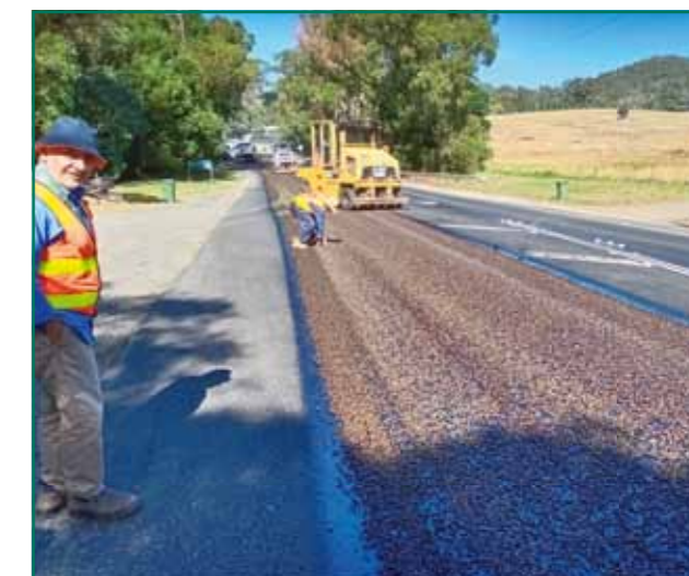
12. ábra: Hot Spray Seal próba PGXpand + CR PMB használatával
