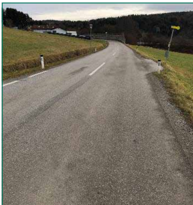
1. ábra: Az út állapota L 384 Lafnitzthal több mint 13 év használat után.
