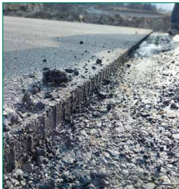
6. kép Eszköz eltávolítása után a kialakult barázdált csatlakozó felület (saját fénykép)
