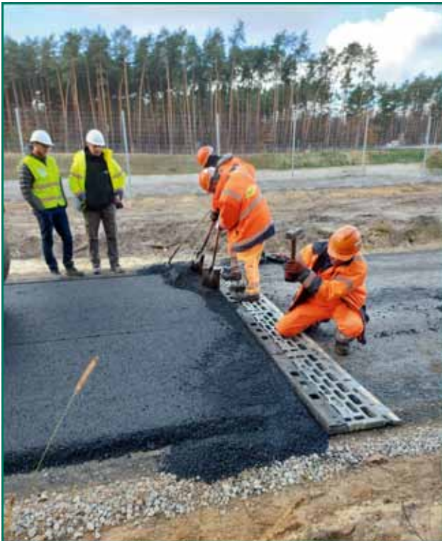
3. kép ReBe beépítése (saját fénykép)
