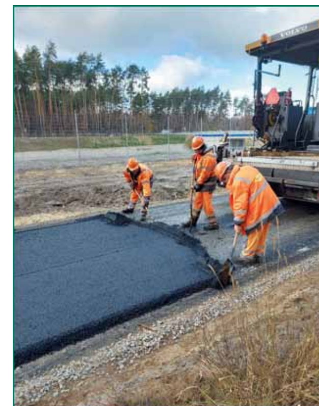
2. kép Szervízút aszfaltozás Lengyelország S19 (saját fénykép)
