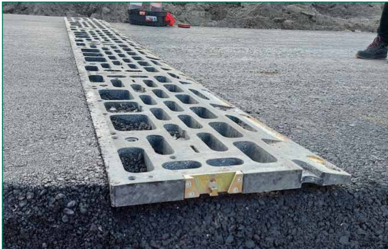
5. kép ReBe eszköz kopóréteghez építve (saját fénykép)
