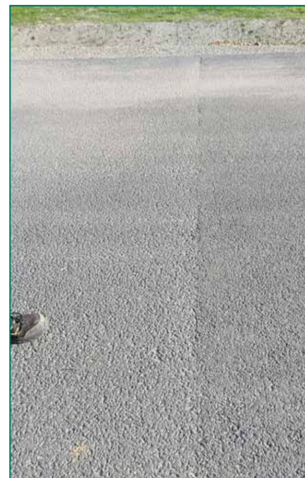
8. kép Korábban elkészült munkahézag ReBe eszköz segítségével (saját fénykép)
