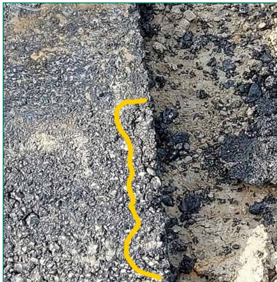
9. kép Friss, meleg burkolat mellől eltávolított eszköz után maradt letörés (saját fénykép)
