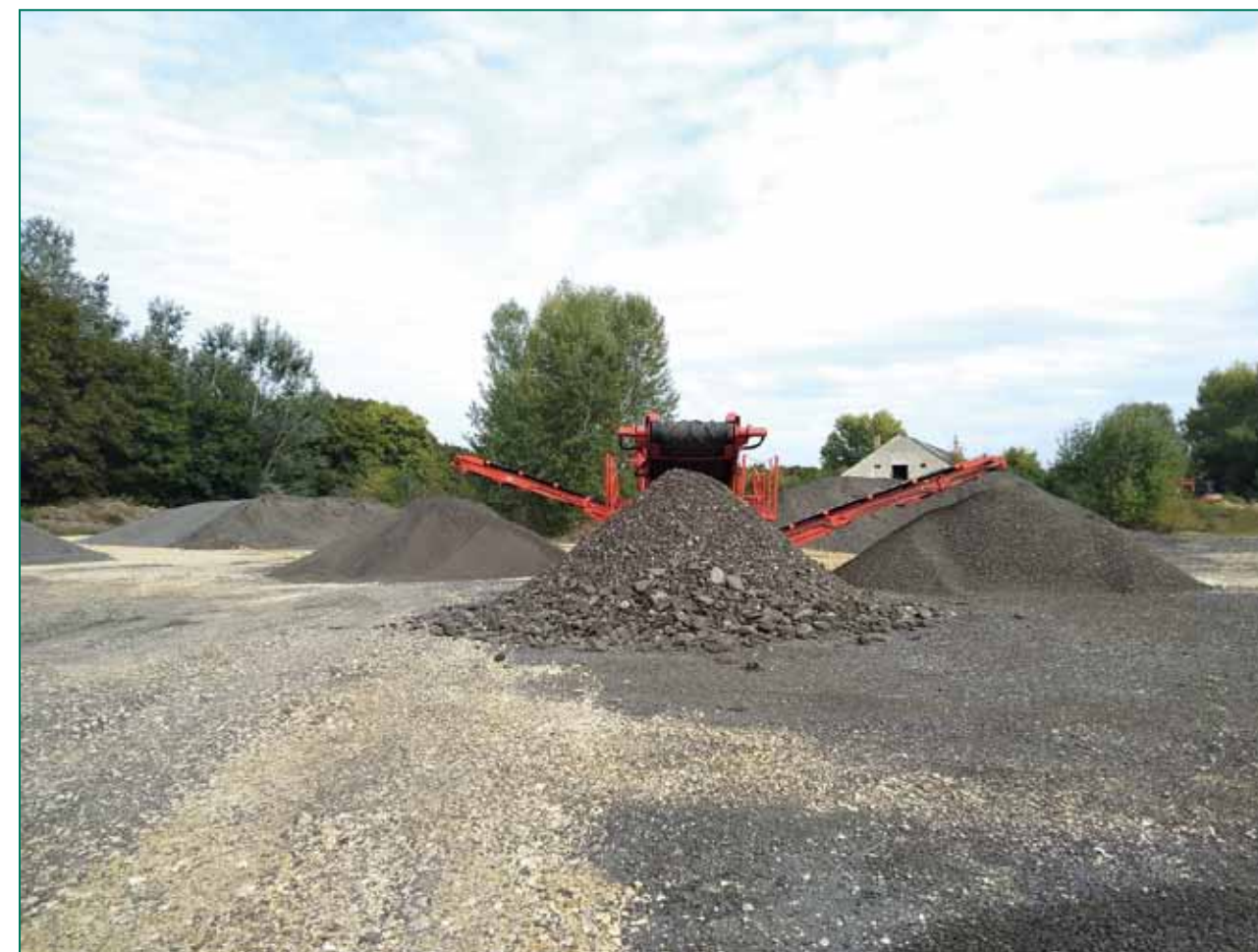
1. ábra: Visszanyert aszfalt osztályozás a keverőtelepen
