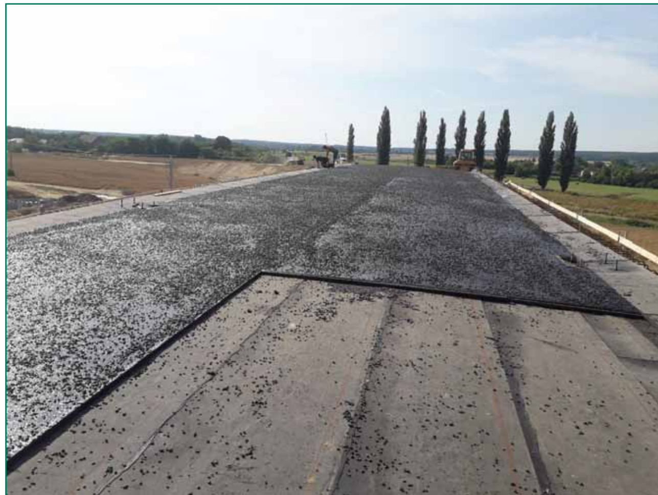
4. ábra: Öntött aszfalt készítése
