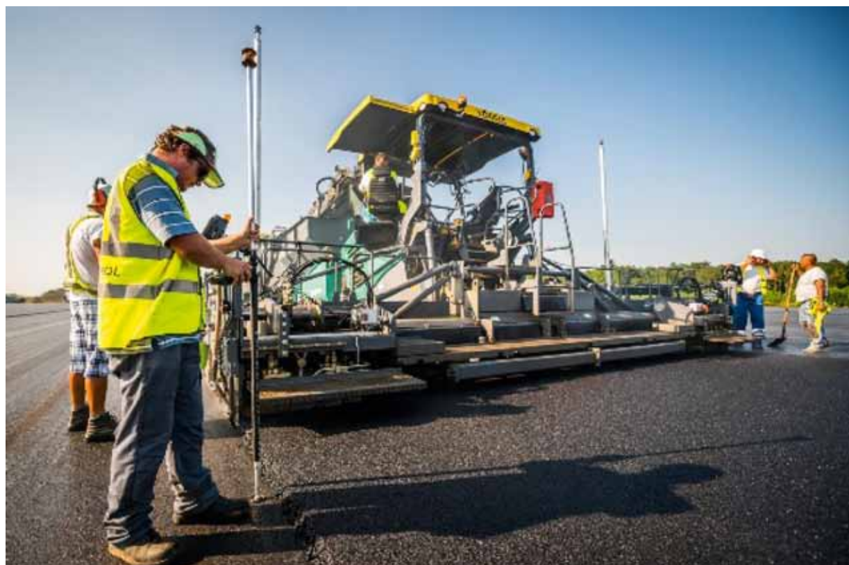
1. ábra: Mérőállomással történő felület ellenőrzés prizmatot és távvezérlő tablet segítségével
