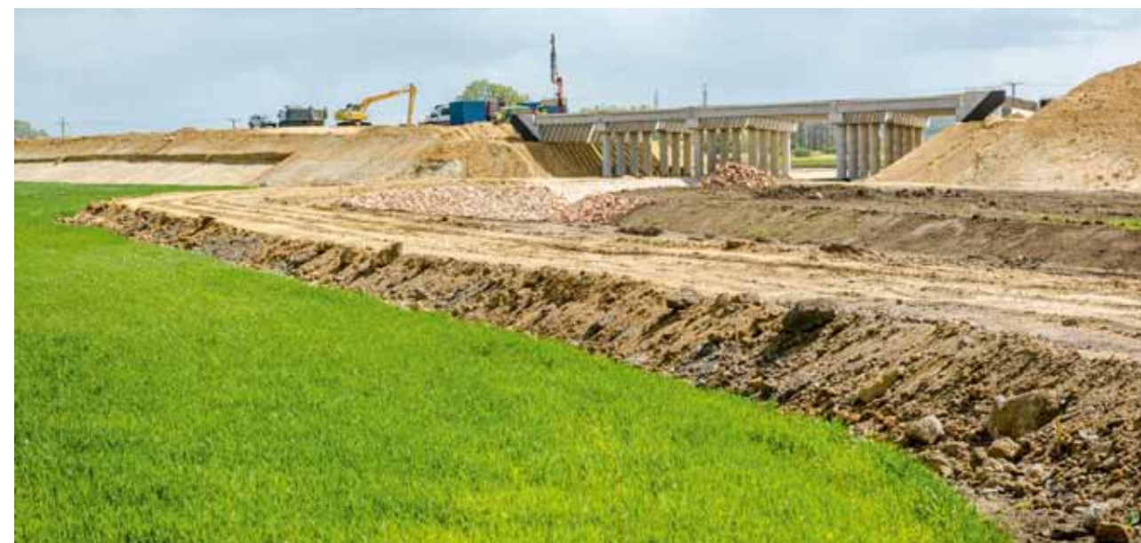
3. ábra: Elkészült támaszok, rögzített híderendák
