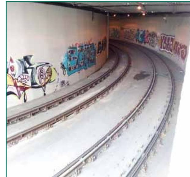
9. ábra. Lánchíd alagút, budai oldal
