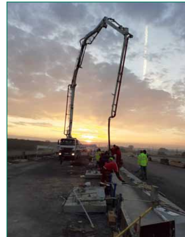
5. ábra: Közbeső szegélyek betonozása
