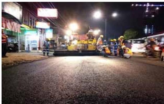
Dzsakarta –Meleg aszfalt: 30% RAP + Iterlene ACF 2001
