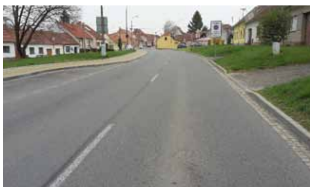
9. ábra: Lednice – az út állapota 4 év használat után
