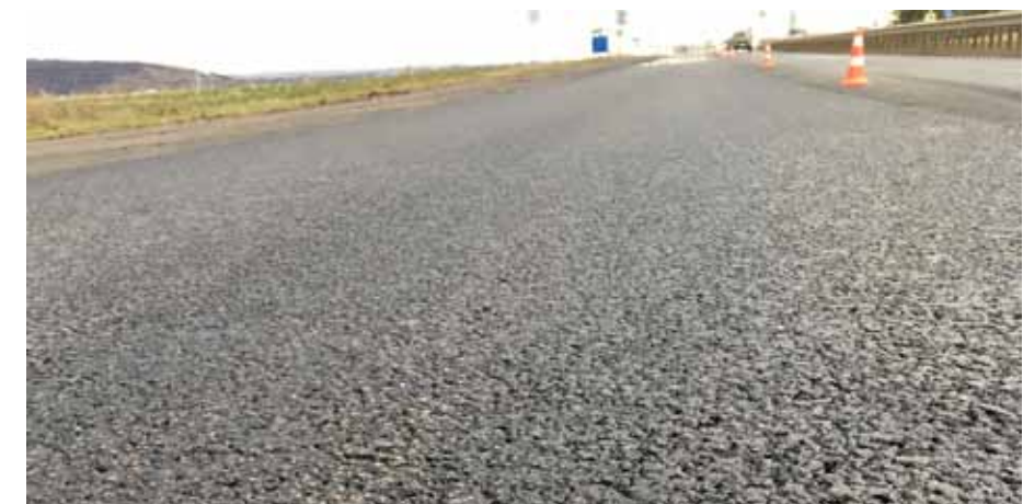
6. ábra Elkészült SMA 20 aszfalt kopóréteg
