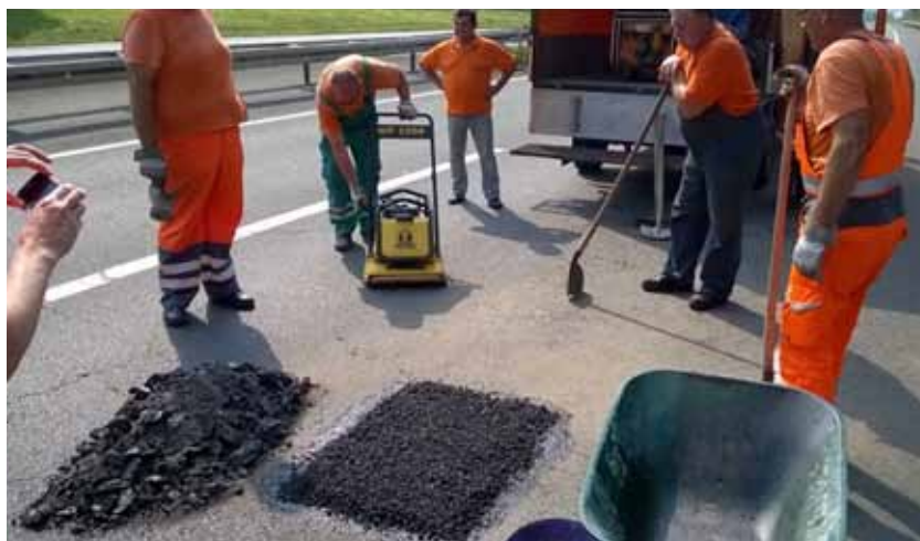
Horvátország (A1 Autópálya) 100% RAP + Iterlene ACF 1000 HP Green
