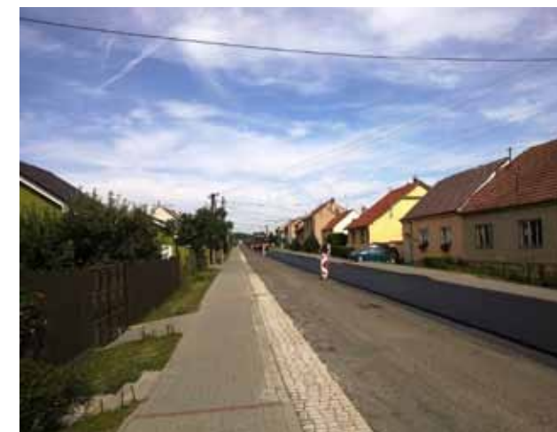
6/a és 6/b ábra: Tervezési hely Domasov 602 út [Google Earth] (balra) és az AC 11 kopó réteg bedolgozva (jobbra)
