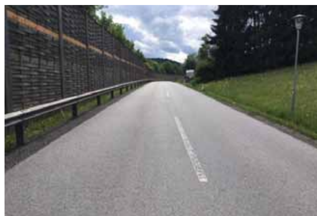
5. ábra: Az L 384 Lafnitzthal út állapota 9 év használat után
