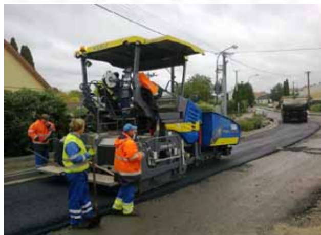
8/a és 8/b ábra: Tervezési hely (Lednice [Google Earth] (balra) és AC 22 kopó réteg bedolgozása (jobbra)
