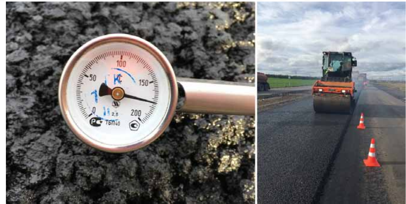
5. ábra A finisher után mért aszfalt hőmérséklet (kb 175°C) és a hengerlés
