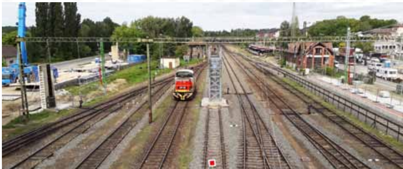
6. ábra: Ideiglenes állvány vasúti vágányzár védelmében
