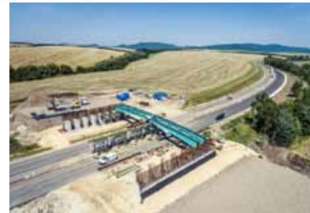
6. ábra: A 21. sz. úton épülő vadátjáró műtárgy
