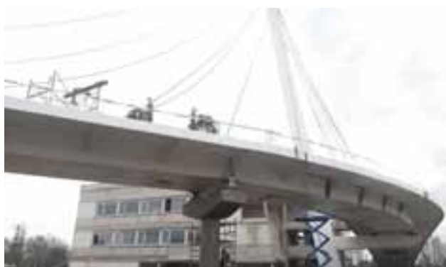
2. ábra: Gyalogos és kerékpáros híd építés közben
