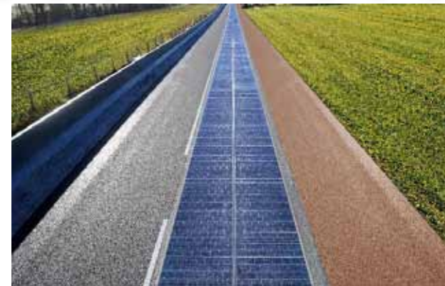
8. ábra: Franciaországban (balra) [14] és Kínában [15] épített napelemes burkolatú pályaszakasz
