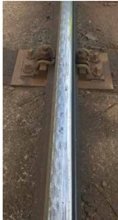
5. ábra: Hullámosan kopott sínszál
