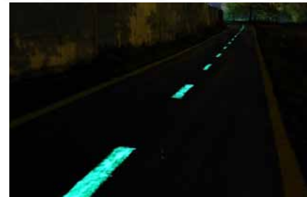
5. ábra: Studio Roosegarde által (balra) és Magyarországon fejlesztett fluoreszcenciás burkolati jelek [9]
