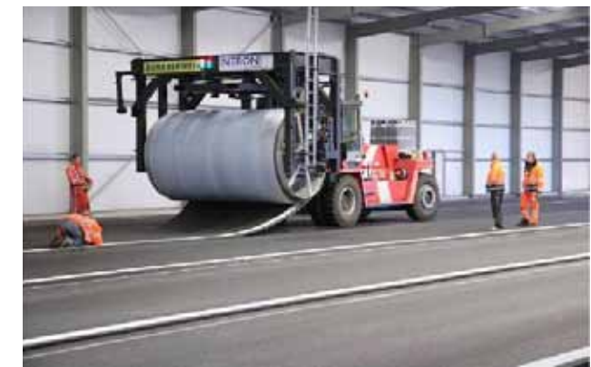
3. ábra: a Rollpave rendszer a gyártás után, feltekerés közben [7]
