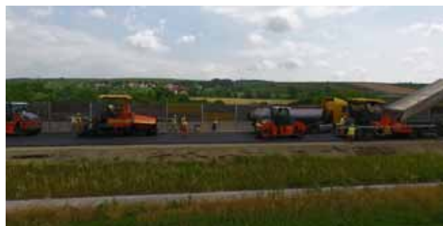
15 sz. ábra: két bedolgozó soros beépítés (2)
