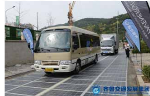
8. ábra: Franciaországban (balra) [14] és Kínában [15] épített napelemes burkolatú pályaszakasz
