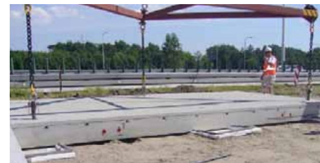
2. ábra: Modieslab pályaszerkezet építése [7]
