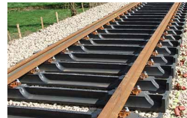
2. ábra: Folyópályába beépített műanyag keresztaljak
