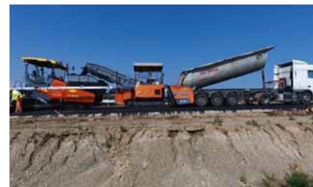
20 sz. ábra: Aszfalt átrakó-előadagoló
