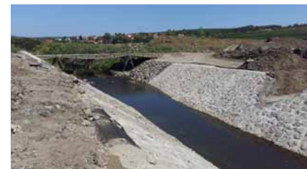
9 sz. ábra: Ideiglenes híd az Eger patak felett
