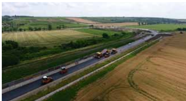
14 sz. ábra: Két finisheres meleg slusszos kopórteg építés
