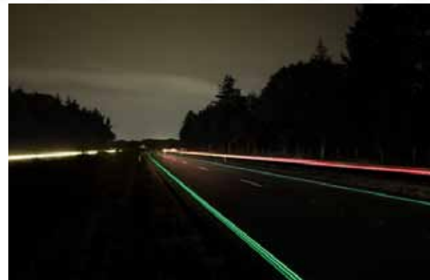
5. ábra: Studio Roosegarde által (balra) és Magyarországon fejlesztett fluoreszcenciás burkolati jelek [9]
