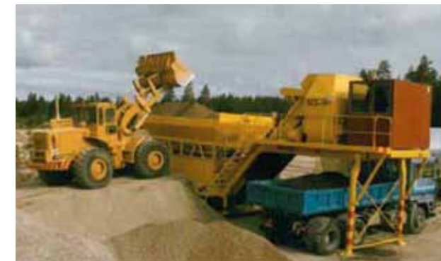
Mobil hidegaszfalt keverőgép munka közben
