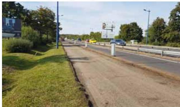
1. kép: Fogadófelület előkészítése, 8 cm marás
