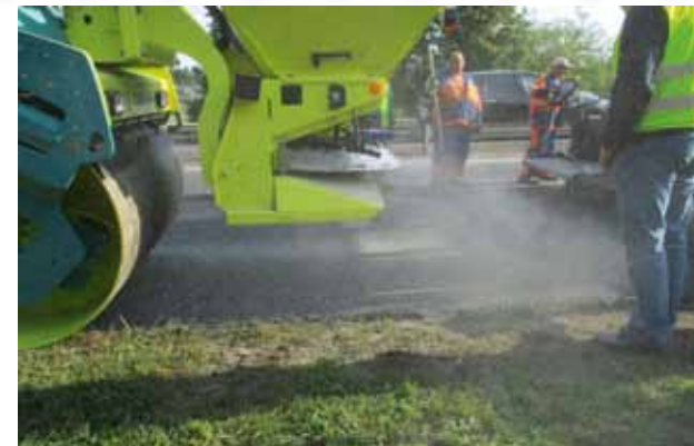
5. kép: AMMANN henger a KZ 2/4 zúzalék szórásával egy időben megkezdte az előtömörítést
