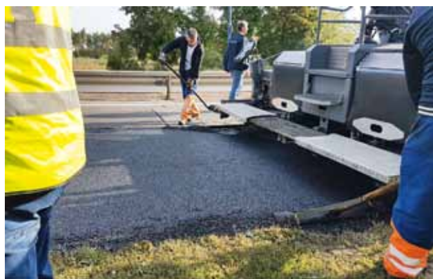
3. kép: 8cm SMA 11 HVA aszfalt terítése egyenletes vastagságban, kiegészítő kézi munkával
