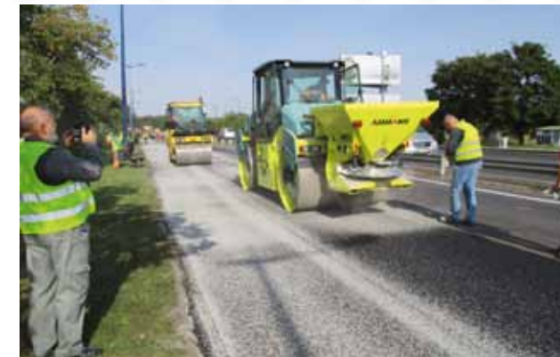
6. Fénykép, Tömörítés kiegészítése a sima felület érdekében acélköpenyes palástú BOMAG BW154 AP úthengerral
