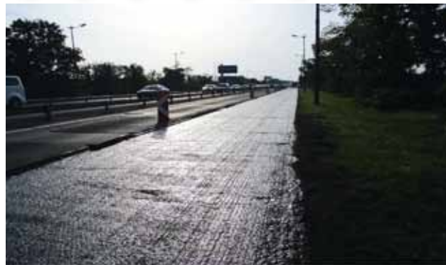
2. kép: Letisztított és kellősített felület
