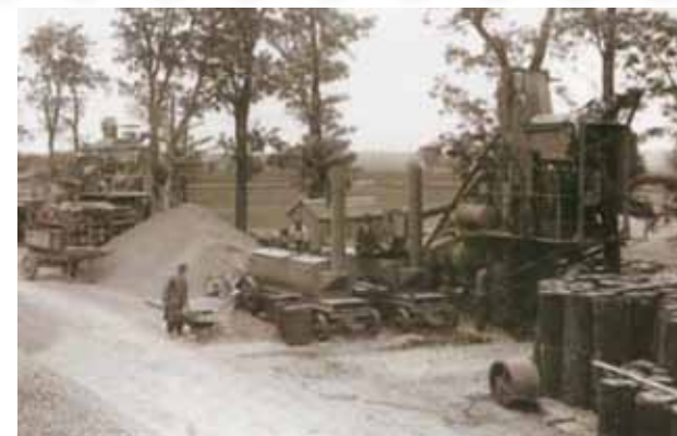
Korai aszfaltkeverő telep
