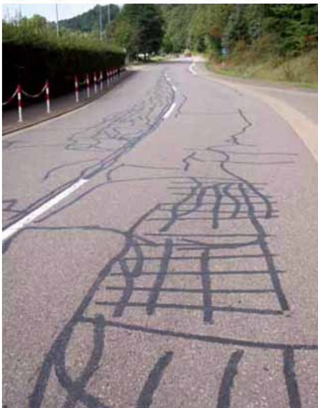
Repedésjavítás
