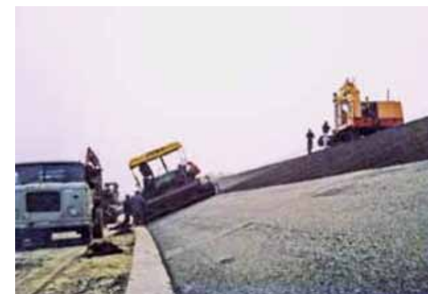
Víztározó töltésének aszfaltozásai
