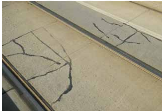
3. kép: repedéskezelés utáni bazaltbeton burkolat Szegeden, a Kossuth Lajos sugárúton
