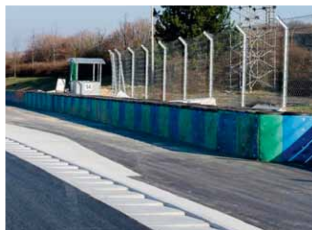
15. kép: Új gumifal szakasz az 5-ös kanyar bukóterében
