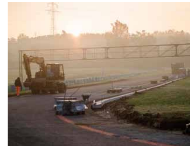
11. kép Szegélyépítés a 13. kanyarban
