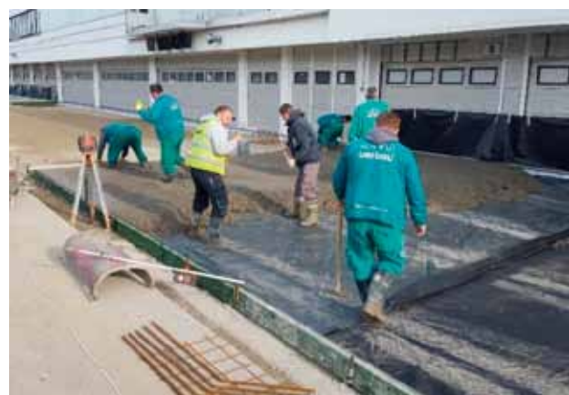
7. kép Beépítés, tömörítés
