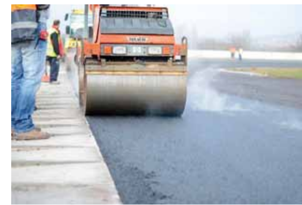
3. kép: A csatlakozások széleinél kishengereket alkalmaztunk
