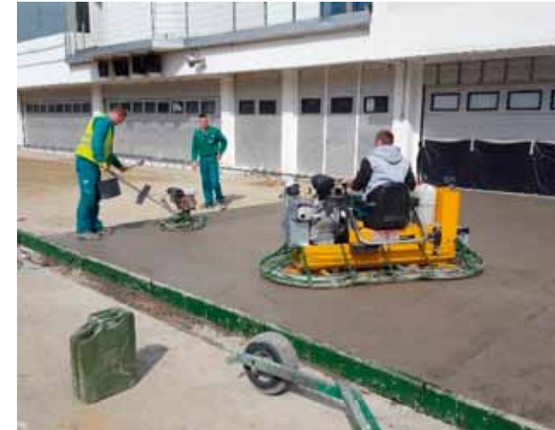
8. kép: Simítás tárcsás simítóval
