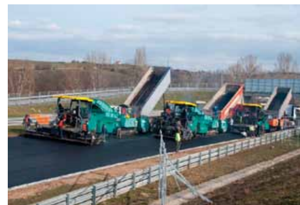
2. kép: Három finisher egyidejű munkavégzése a pálya egyik legszélesebb szakaszán
