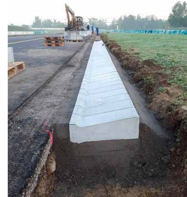
12. kép: Vízvezető szegélysor építése
