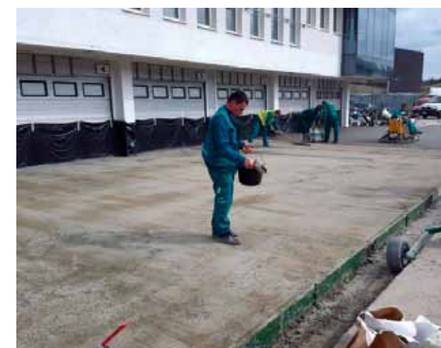
9. kép: Kéregerosztó bedolgozása
