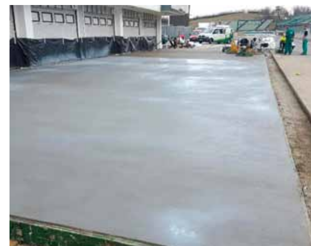
10. kép: Ismételt simítás utáni, elkészült felület
