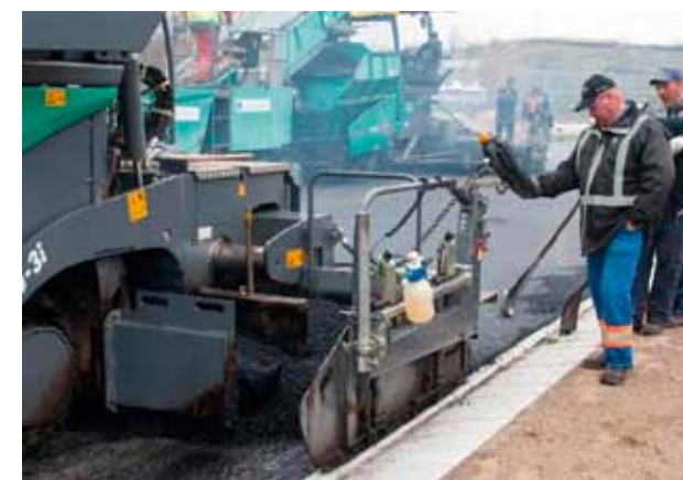
4. kép: Zárás az elkészült szegélyekhez
