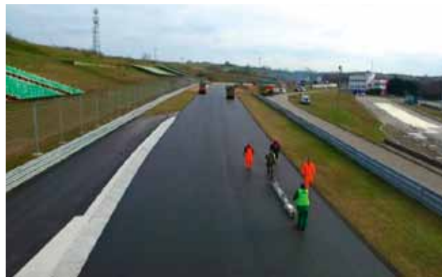
6. kép: Építés közbeni UT-02 hullámosságmérés
