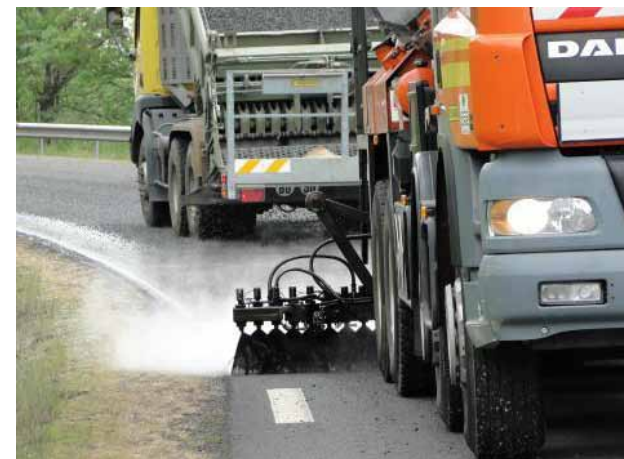
Bitumenemulzió szórás
