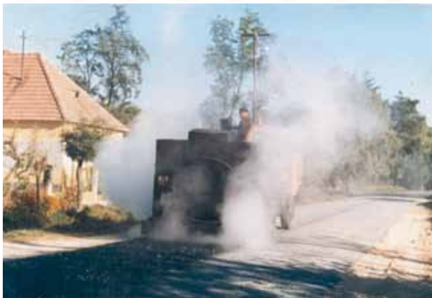
14. kép Úgynevezett itatásos hengereléssel javítanak útburkolatot Ostffyasszonyfán (1980-as évek körül)
