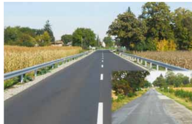
18. kép - 26143 j. út felújítást követően
