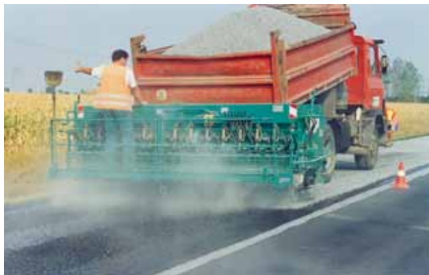
15. kép - Felületi bevonat készítése
