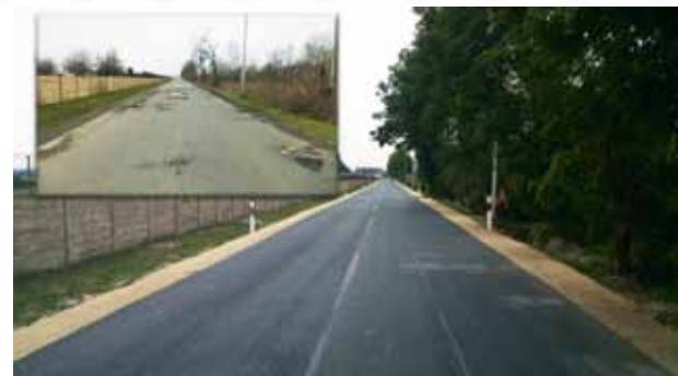
17. kép - 5101 j. út felújítást követően
