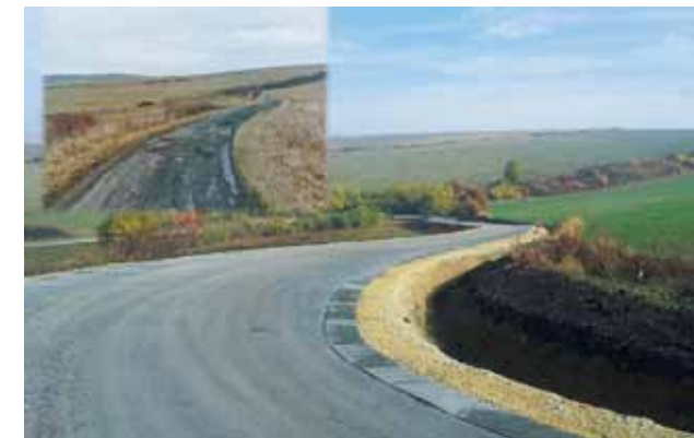
19. kép - 6616 j. út felújítást követően
