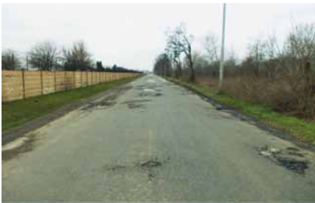
16. kép - Felújítás előtt az 5101 j. út
