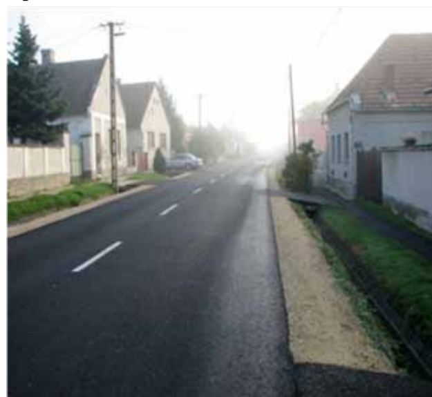
4. ábra Felújítás előtti és utáni állapot alkalmazott technológia: - Lokális pályaszerkezet csere -Burkolat megerősítés két rétegben
