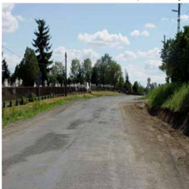
5. ábra Felújítás előtti és utáni állapot alkalmazott technológia: - Burkolat megerősítés egy rétegben; -Burkolat megerősítés két rétegben -Lokális pályaszerkezet csere; -Burkolat szélesítés
