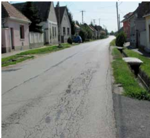
4. ábra Felújítás előtti és utáni állapot alkalmazott technológia: - Lokális pályaszerkezet csere -Burkolat megerősítés két rétegben
