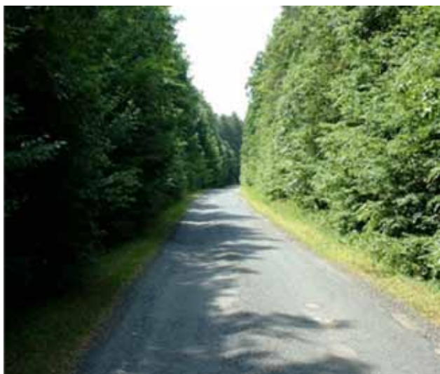
6. ábra Felújítás előtti és utáni állapot alkalmazott technológia: -Burkolat megerősítés két rétegben; -Lokális pályaszerkezet csere
