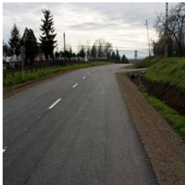
5. ábra Felújítás előtti és utáni állapot alkalmazott technológia: - Burkolat megerősítés egy rétegben; -Burkolat megerősítés két rétegben -Lokális pályaszerkezet csere; -Burkolat szélesítés
