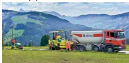
5. kép. AFT 350 E finisher-t használtak a károsanyag-kibocsátás-mentes aszfaltozáshoz. Az aszfaltot a rubigeni aszfaltkeverőtől szállították, ami kb. 1,5 óra távolságra van a farmtól.
