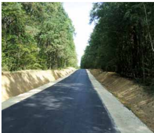
6. ábra Felújítás előtti és utáni állapot alkalmazott technológia: -Burkolat megerősítés két rétegben; -Lokális pályaszerkezet csere
