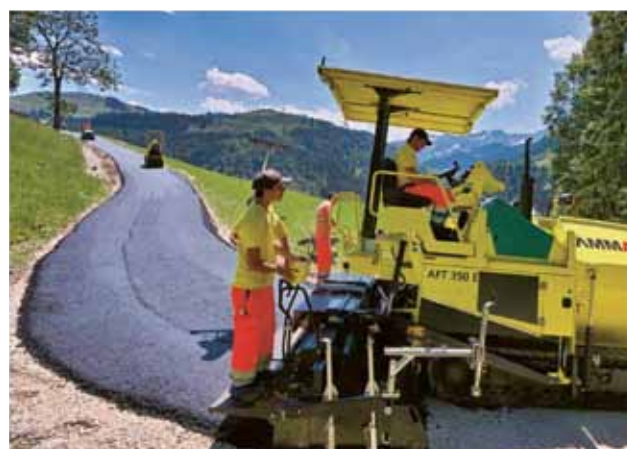
1. kép. Viszkózitási tulajdonságai jelentik az alacsony hőmérsékletű aszfalt egyik fő előnyét. A „hidegebb” aszfalt bedolgozása sokkal egyszerűbb feladat, különösen meredeken lejtőkön lévő utak esetében.
